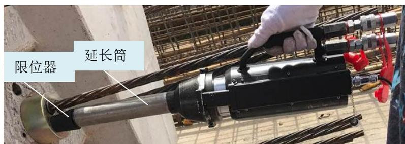
图 4.2 安装千斤顶示意图
